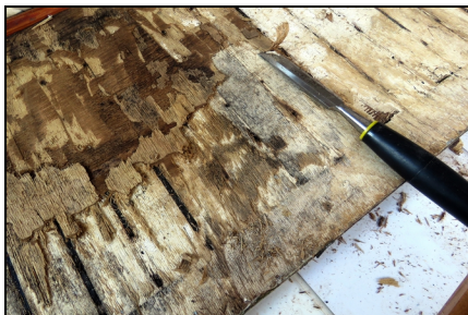
Décapage du CP pourri côté assise et côté teck
