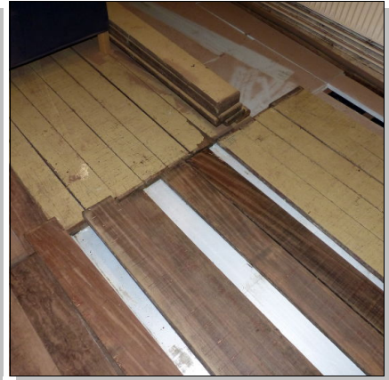
Avant et après ponçage
