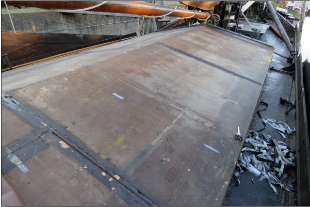
Mise à nu de l'ancienne couverture
