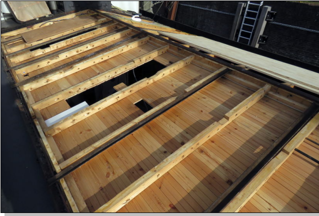
Le toit débarrassé des câbles électriques disgracieux, Ouvertures découpées dans les lambris entre les chevrons
