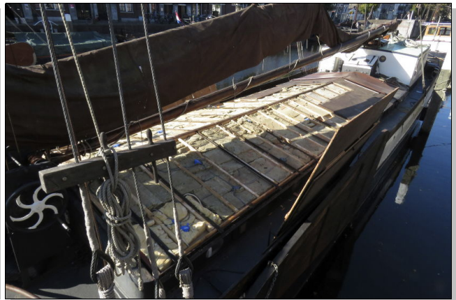
Démontage du contreplaqué
