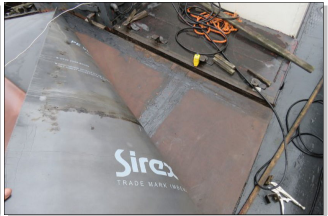
L'isolation (Sirex AS 5 mm d'Imbema) entre la bâche et la structure en contreplaqué
