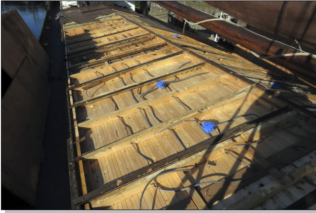
Mauvaise surprise : une forêt de câbles électriques ayant prospéré comme du chiendent impose de retirer l'irritante isolation en laine de verre. Le Cap' se décide donc à refaire le réseau électrique
