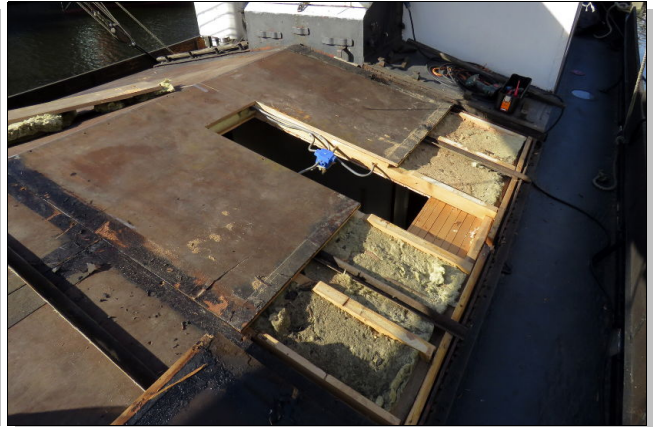
Essai d'ouverture d'un lanterneau dans le toit (6 sont planifiés)
