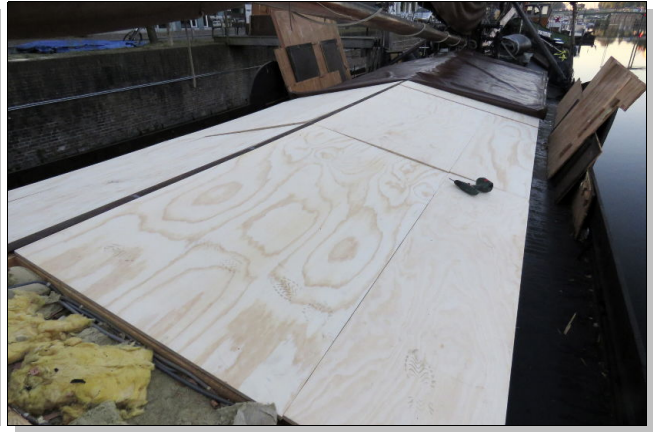
Installation provisoire des nouveaux panneaux en contreplaqué. Dur-dur ! Lourds-lourds ! Faire et défaire, ils seront souvent dévissés, déplacés et remis en place le soir.
