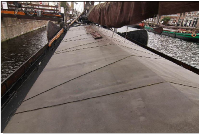
La bâche imperméable existante
